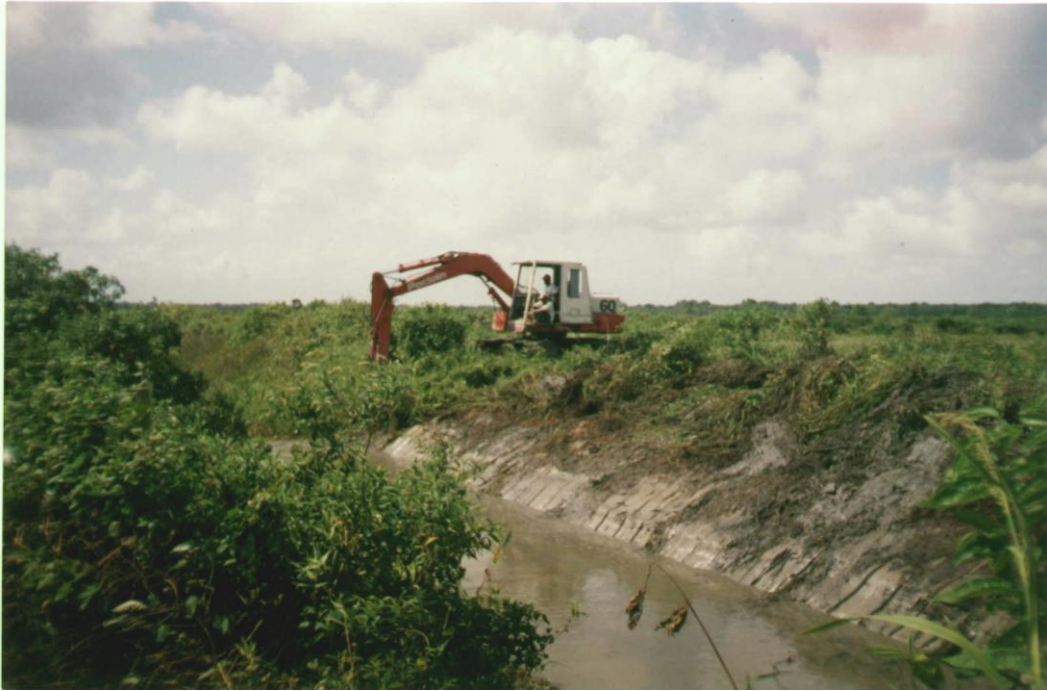
Foto 1: Een hydraulische graafmachine (HGM) bezig met het opschonen van een dichtbegroeide irrigatieleiding
